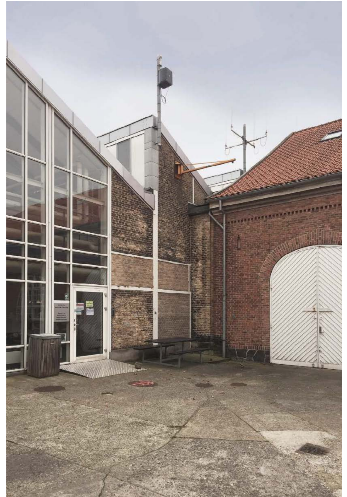
Det sammenbyggede møde mellem Torpedomagasinet og Torpedoværkstedet. Torpedoer er transporteret fra Torpedoværkstedet gennem Torpedomagasinet til kajen, hvis torpedoerne skulle videre til torpedobådene, som lå fortojet til de tidligere anløbsbroer. Før anlæggelsen af Torpedoværkstedet er torpedoer - højst sandsynlig - transporteret fra Søminevæsenets Værkstedbygningen via sporvejen og ind gennem porten i Torpedomagasinet.
