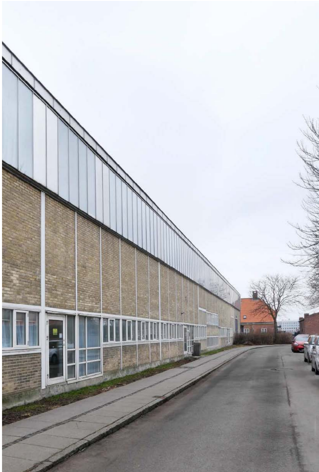
Den nordlige facade af Torpedoværkstedet, hvor bygningens taktfulde konstruktion er særlig tydelig. På grund af de lodretstillede vinduer i shedtaget, forlænges bygningens facade elegant i højden. Shedtagsbygninger bygget før Torpedoværkstedet har vinduer i konstruktionen, der er mere skråt stillet. De lodretstillede vinduer ses oftest i tilsvarende shedtagsbygninger fra omkring 1950, hvorved Torpedoværkstedet skiller sig ud ved at placere sig i mellem to perioder. For enden vejen af ses det nordlige Torpedobåskammer og Ubådsbygningen, hvor mellemrummet mellem bygningen muliggør udsyn på tværs af havneløbet.
