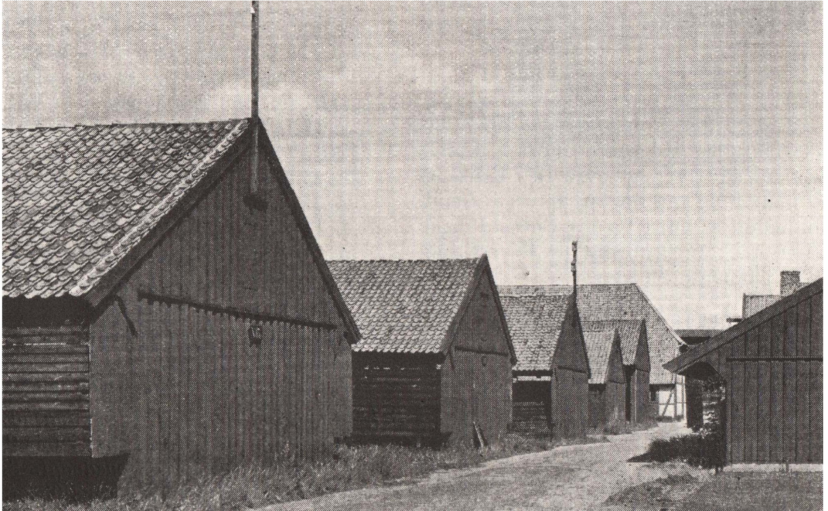
(Holmens bygningshistorie 1860-1930, Christian Elling, 1933). De sydlige tømmerskure med deres repetitive struktur på Nyholm.
