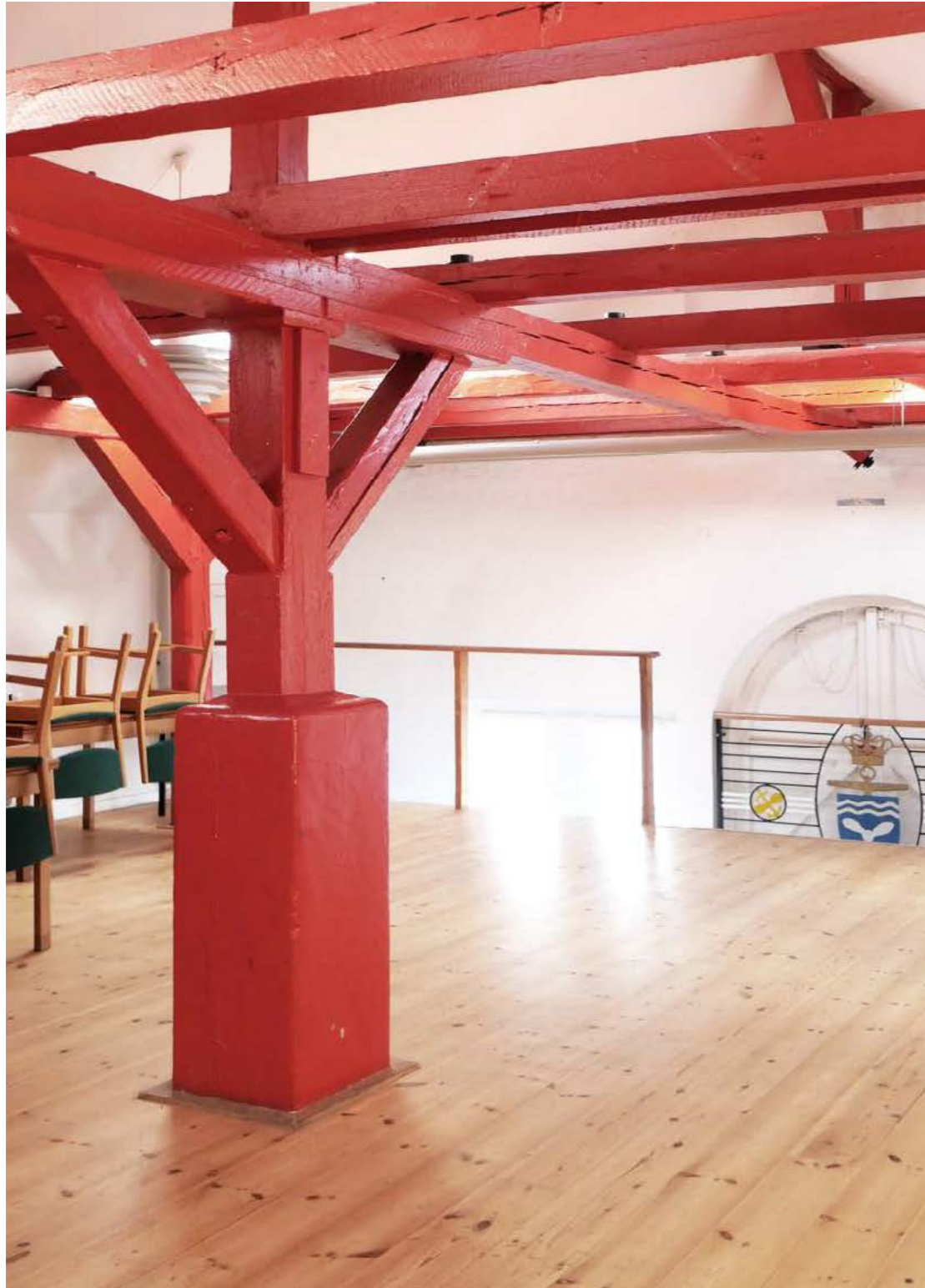
4 Torpedomagasinet's øvre tømmerkonstruktion er letflæselig, hvor hjørnebåndene er synlige, og tømmerkonstruktionen har derved et let og åbent udtryk.
