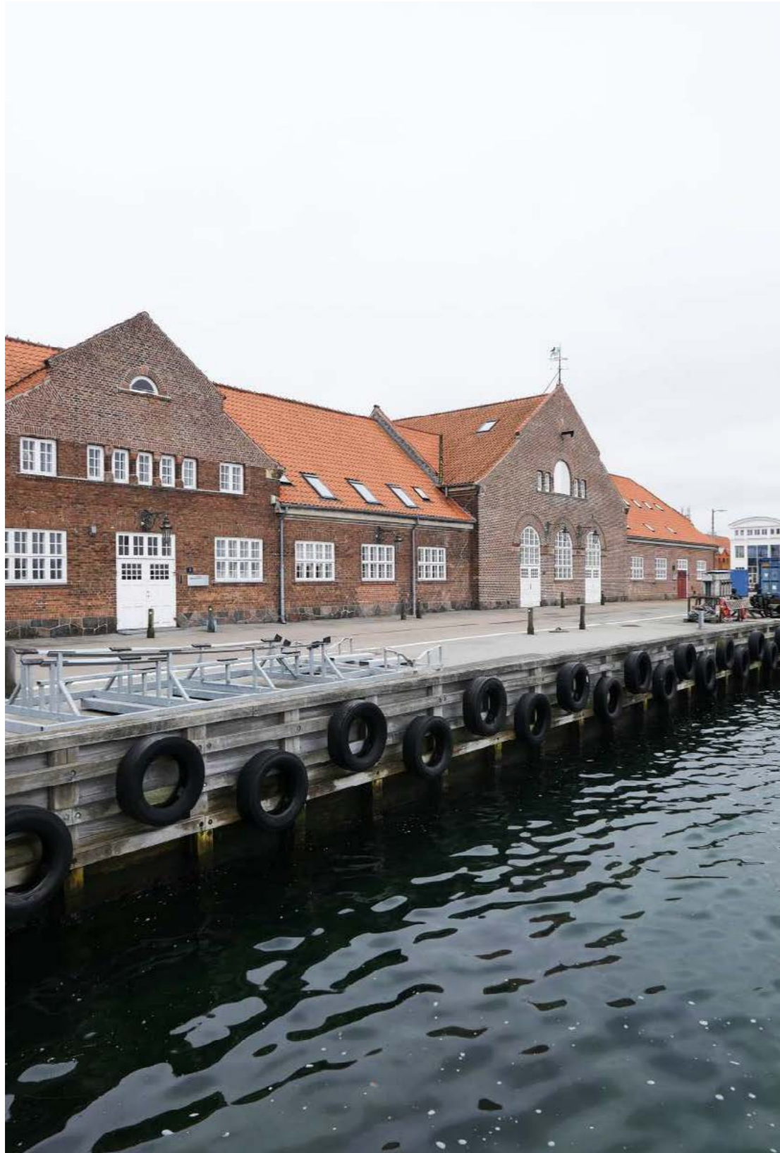
Bygningernes tætte relation til vandet ses tydeligt i deres placering tæt på kajen, samt i det fritholdte kajareal med udsyn ud over havneløbet. Bygningernes ankomstsider mod vandet understreges desuden i facadernes orientering og høje detaljeringsgrad mod kajen. Torpedobådskammerets og Torpedomagasinets arkitektur er således både funktionsbestemt og underlagt de nationalromantiske træk.
